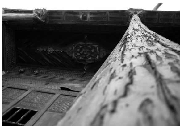
تصویر ۱۷ - رفعت ایوان اصلی خانه (در دو طبقه) و تزئینات آینه کاری بر روی چوب در سقف آن.
