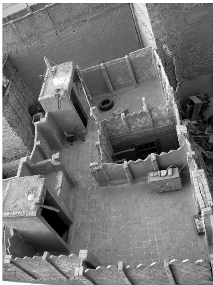
تصویر ۵- نمونه ای از خانه های عامه؛ حیاط مرکزی کوچک در وسط ضلع سمت راست مشهود است. نکته جالب در این تصویر جان پناه های خانه است که در اکثر خانه های عامه به چشم می خورد؛ این جان پناه ها بام را محصور می کنند تا در شبهایی که هوا مطلوب است، برای خواب مورد استفاده قرار گیرند. چنین عنصری در خانه های اعیانی به دلیل تنوع بیشتر فضاهایی مانند ایوان های رفیع، مشربیه ها و وسعت حیاط کمتر به چشم می خورد.
