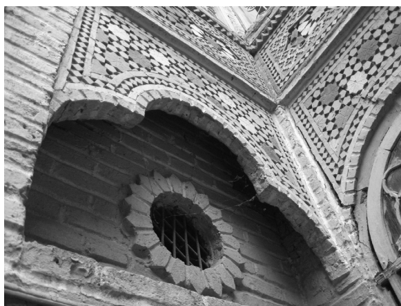
تصویر ۲۷- دوجداره بودن دیوارها، برانی خانه ابومشتاق.
