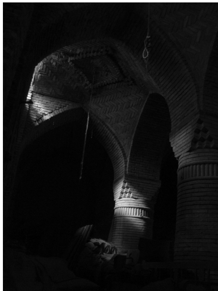
تصویر ۱۲ - سرداب برانی خانه ابومشتاق. نور نورگیر عمودی که به حیاط راه دارد تزئینات آجری را وضوح می‌بخشد.
